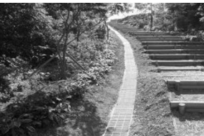
(등산로 배수로 설치)
