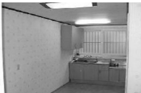
(도배 및 장판 교체 공사 완료)
